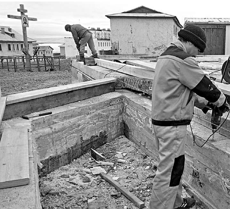
Возведение стен церкви
